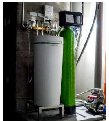
✓ 台南 - 市立美術館一館 設備：全屋式除氯設備 GENO- mat®AK-Z、softliQ 軟水系統
