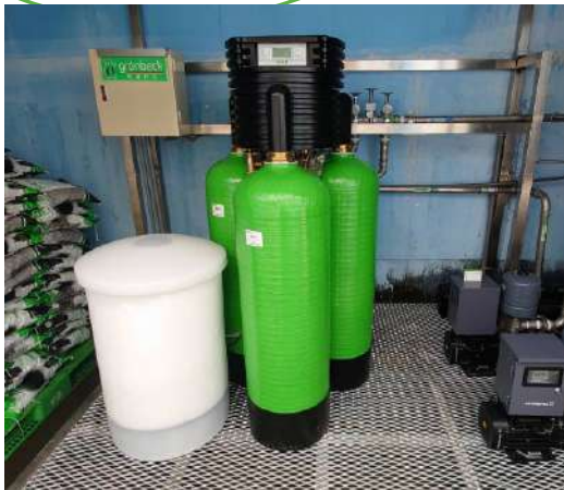
✓ 嘉義 - 大埔自來水廠 設備：Delta-p® 三罐循環軟水系統
