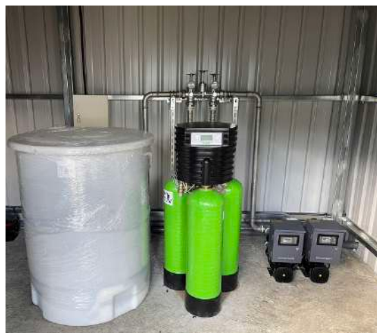
✓ 台南 - 市立美術館一館 設備：全屋式除氯設備 GENO- mat®AK-Z、softliQ 軟水系統
